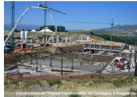
Construction de l'hôpital transfrontalier de Cerdagne, à Puigcerda.
