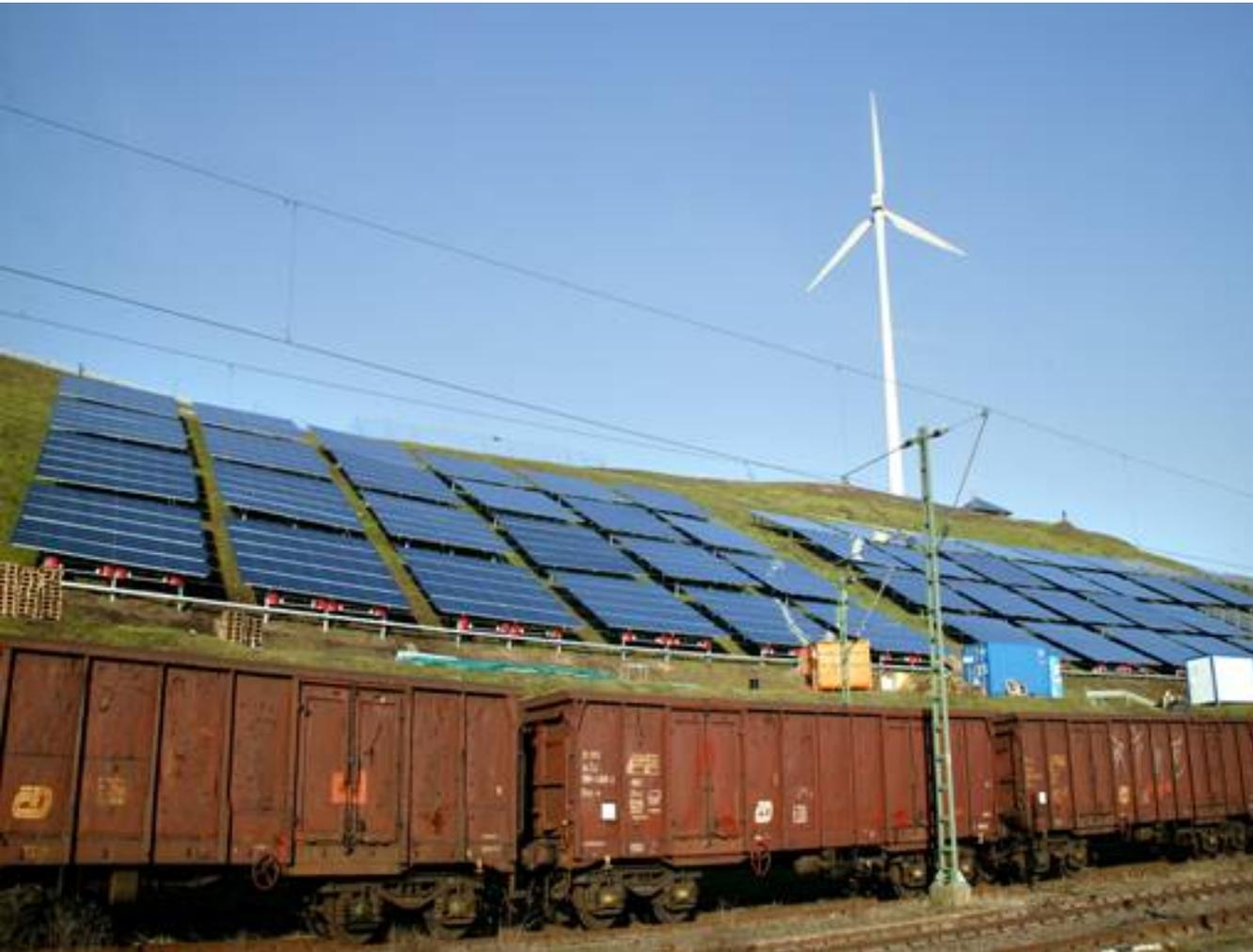
*432 kW, Cadmiumtellurid-Dünnschichtzellen
