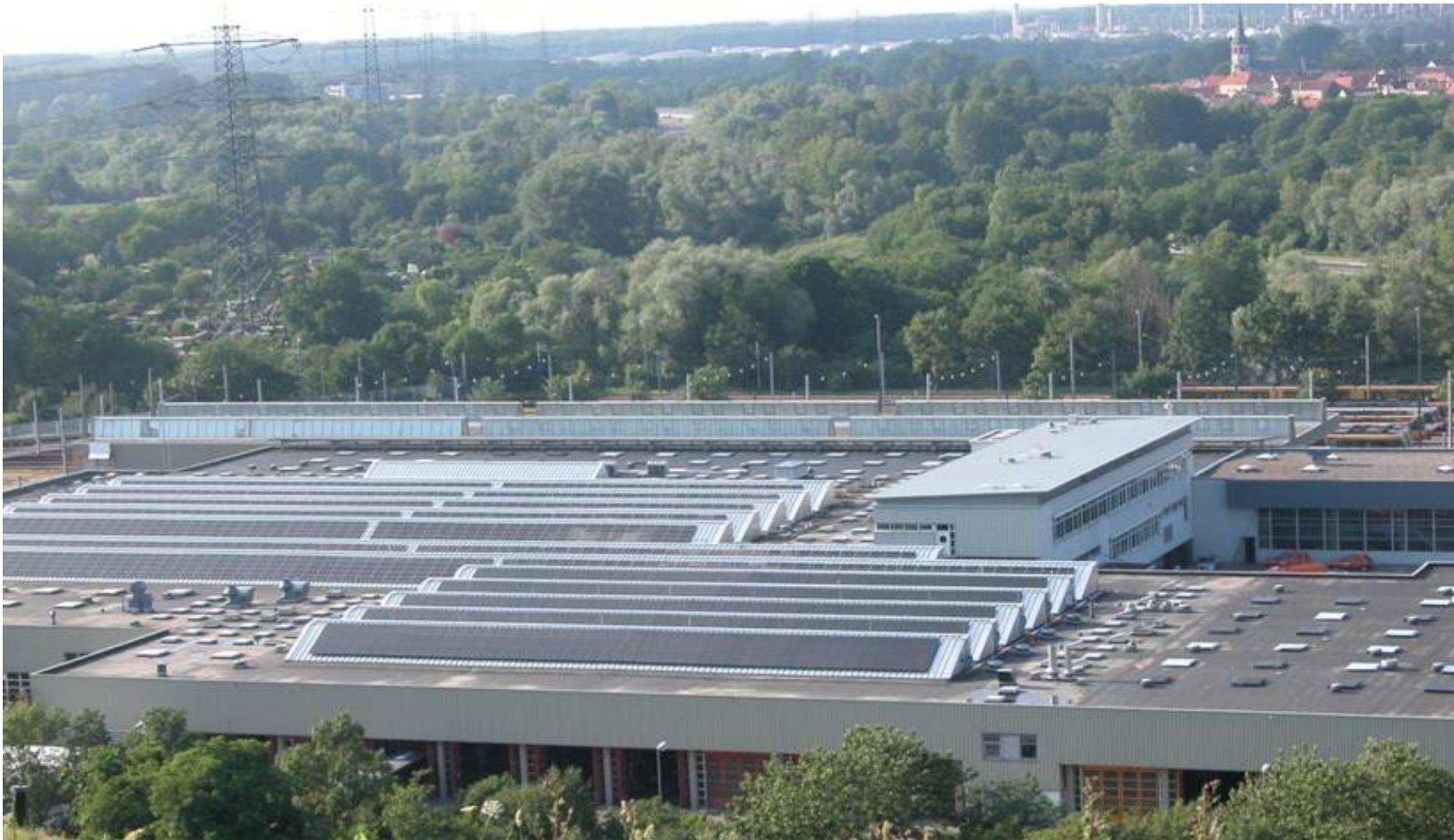
*64 kW, Cadmiumtellurid-Dünnschichtzellen (737 m<sup>2</sup>) und
