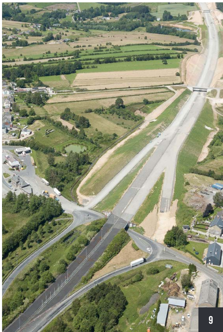
Travaux de raccordement à la frontière
